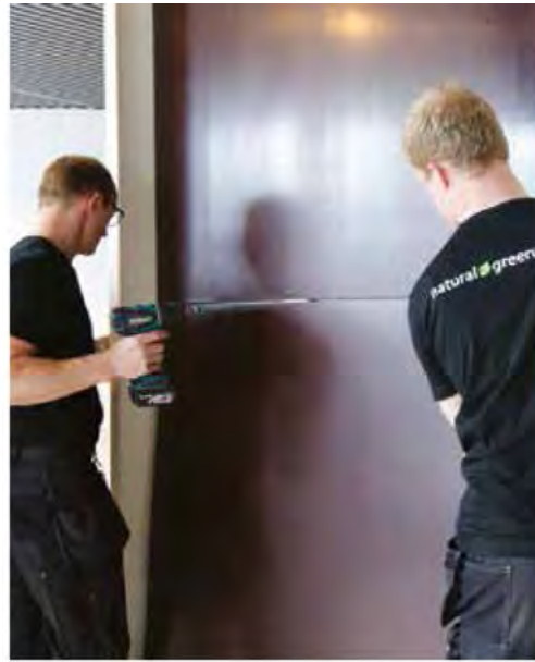
Aufbau der Rückwand mit wasserfesten Platten.
